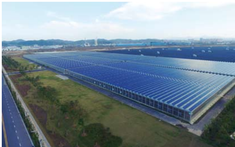
② 光伏产业园俯瞰
