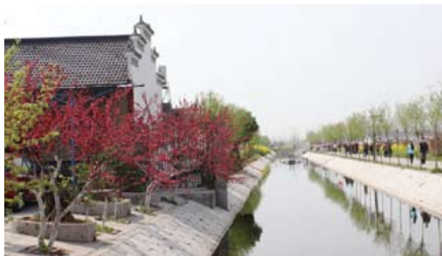
修整后的主排渠
