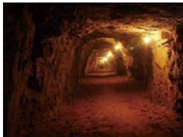
❸ 引水隧洞
