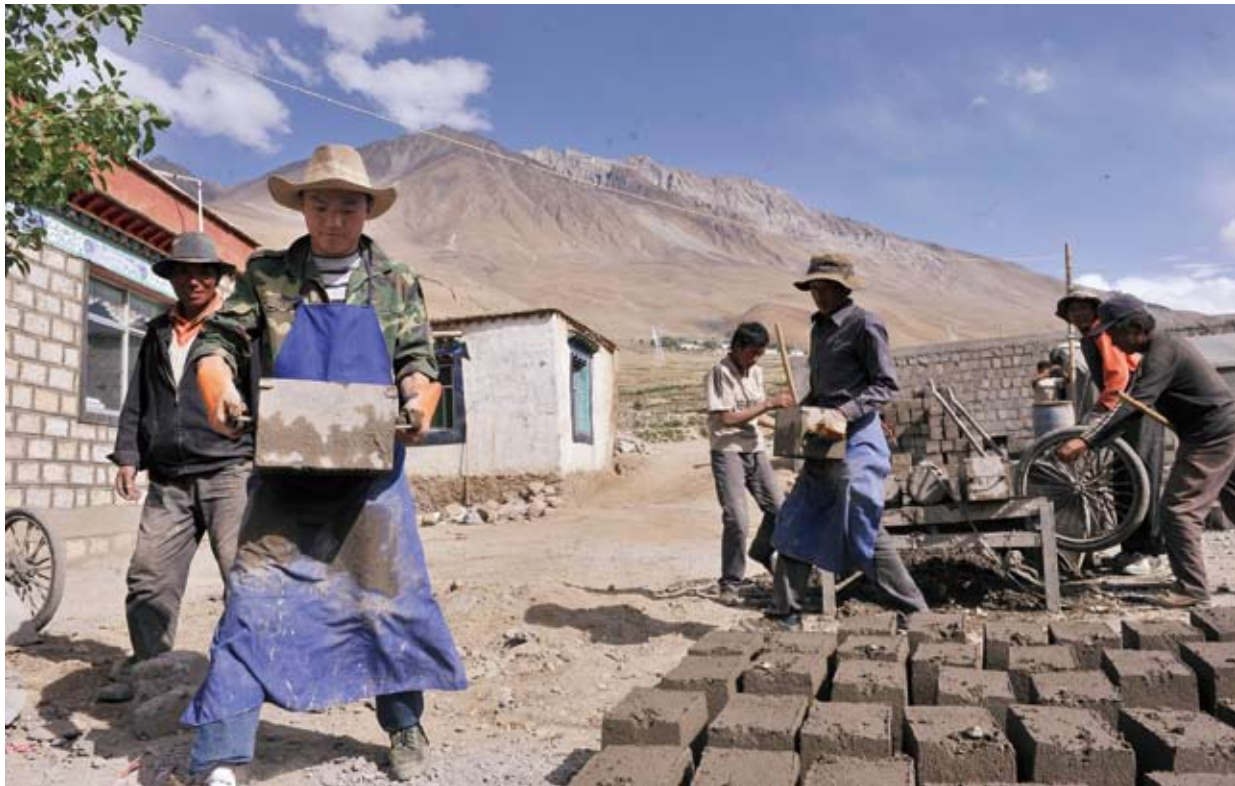
❶ 缺氧不缺精神，在工地上与工人一起同吃同住同劳动
