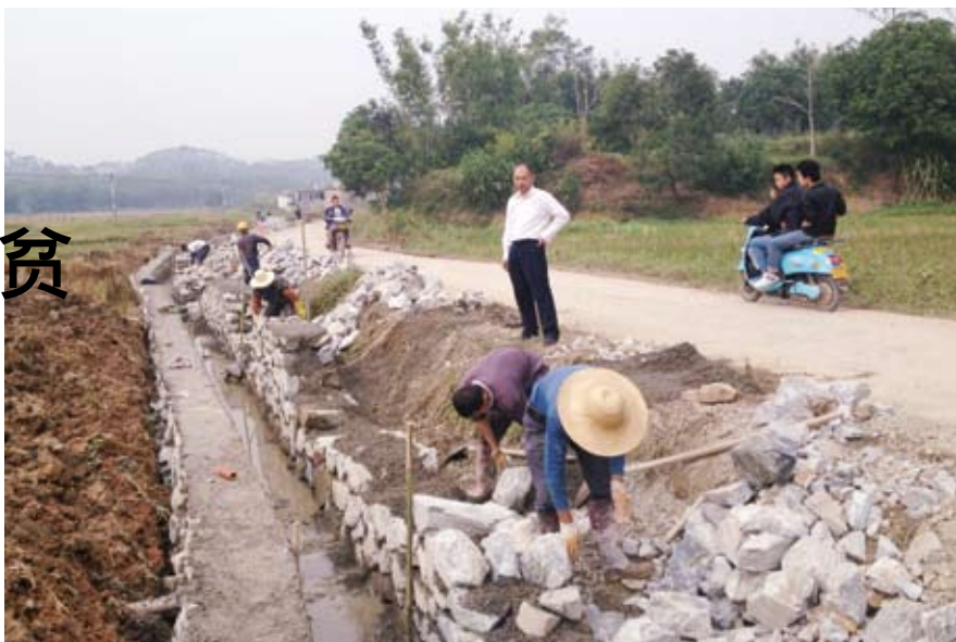
石建德（中）察看公路扩建施工情况
