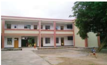
2016年7月，唐侯村小学新教学楼建成并投入使用
