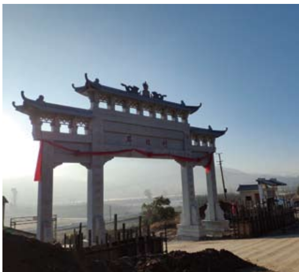
① 耳目村牌楼
