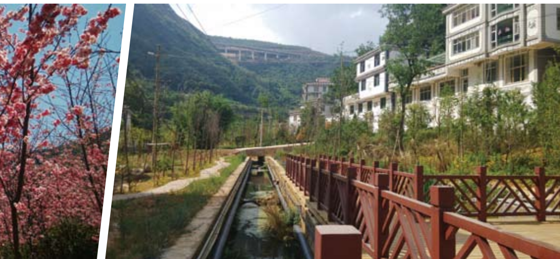
改造后的社区河道
